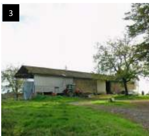
Bâtiment de stockage
