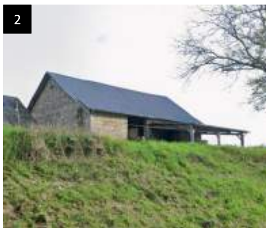
Bâtiment de stockage susceptible de changer de destination
