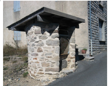
Visuel d'un puits du bourg de Chanteix
